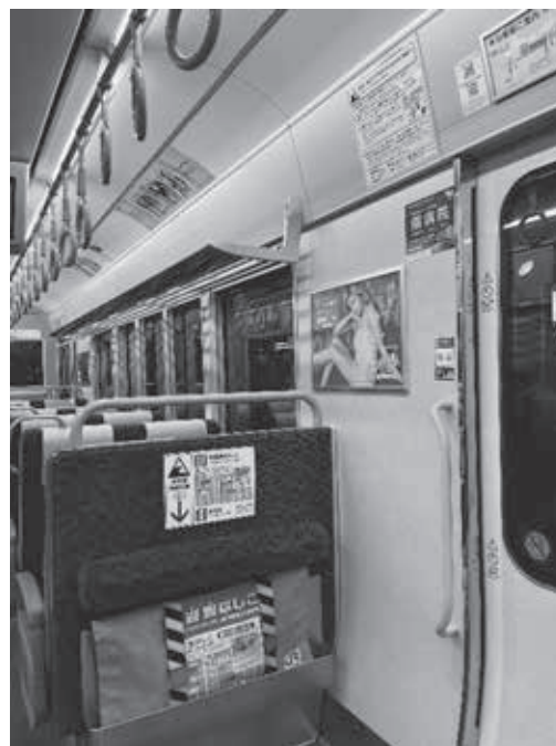
図7 客室内に設置されている避難はしご
