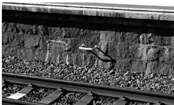
写真2 南海が導入しているホームステップ
