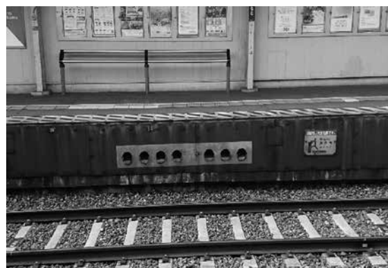
写真1 京阪が導入しているホームステップ
