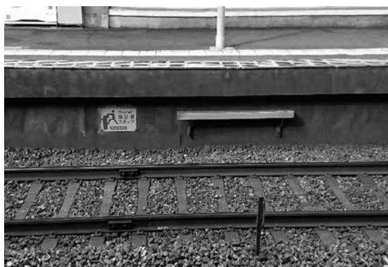
写真1 京阪が導入しているホームステップ
