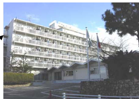
【関西大学南千里国際学生寮 外観】
