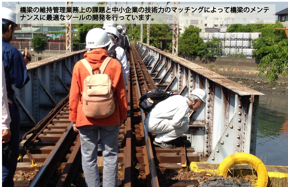
鉄道橋の現状に関する視察状況
