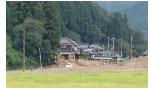
丹波市市島地区 豪雨災害被害箇所
