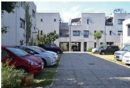
図 24. 敷地内の駐車場と通路の様子
