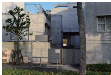
図 8. 竣工後に設置されたゲート
