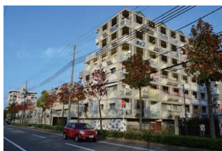
図 4. 前面道路からの全景
