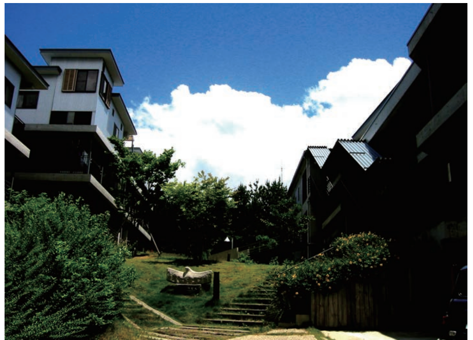
図9. 「つなね」の写真 増築された部分を確認することが出来る
