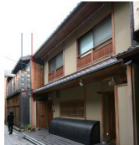
図 17. 三項道路沿いの建物 18)
