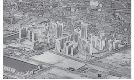
図13.建設直後の武庫川団地(出典:西宮現代史第二巻)
