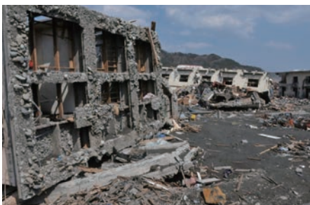
図 17. 新港町の深刻な被害状況 14)
