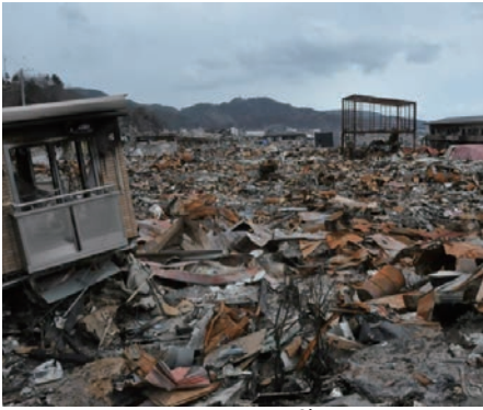
図 10. 大槌町、被災状況 8)
