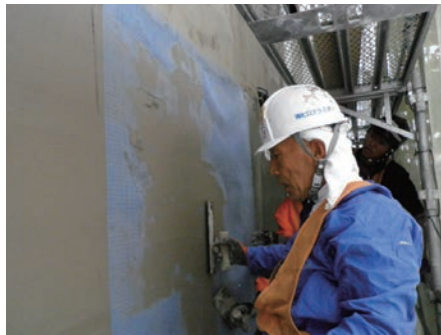
図 12. 外断熱改修の施工の様子 12) 断熱材の貼付 (左) と外壁の仕上げ途中 (右)
