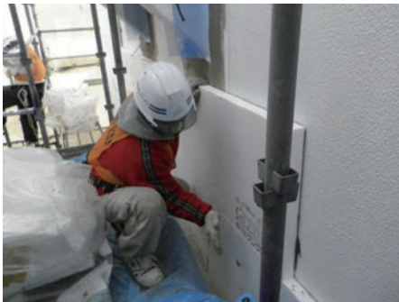
図 12. 外断熱改修の施工の様子 12) 断熱材の貼付 (左) と外壁の仕上げ途中 (右)
