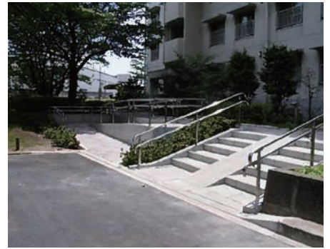
図 5. 住棟アクセスのバリアフリー化 5) 上：従前 下：従後
