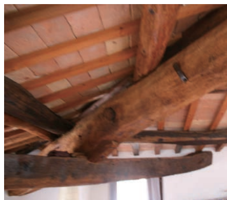
図 13. 古い材(濃)と新しい材(明)の混在 9)
