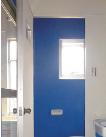
写真.9 トイレ/風呂/洗面所改修後
