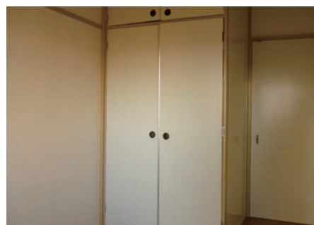
写真.6 和室3畳改修前
