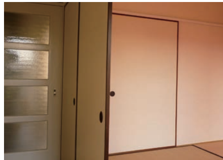
写真.3 和室6畳改修前
