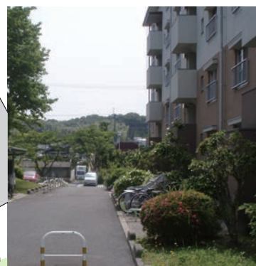
図 8. 階段室周辺の樹木
