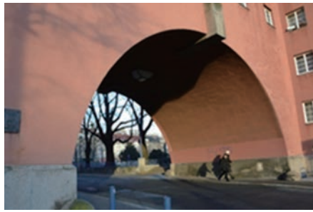
図 6. 道を跨いだ開口部分
