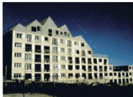
図2. 既存住棟の一部を減築し、増築する
