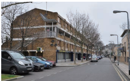
図9. 空中歩廊撤去後の空間
