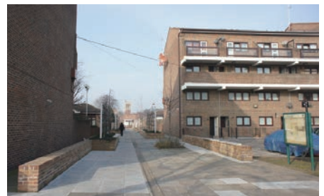
図16. 団地入口部分のテラスハウス
