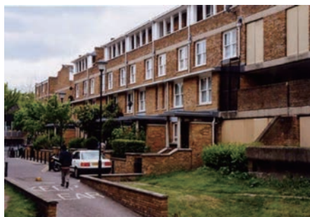
図5.空中廊下を撤去した再生後の住棟 2)
