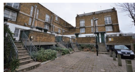
図7.直接アクセスに改修した住棟
