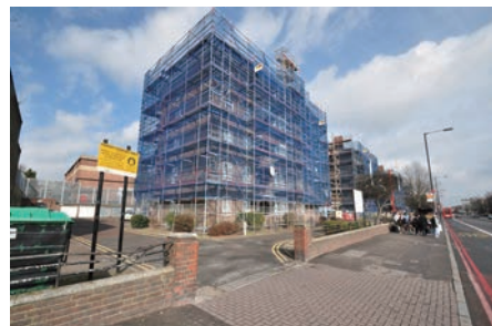
図13. 改修工事中のレンガ造の中層住棟
