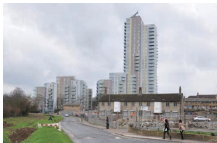
図10. 建設が進む高層棟
