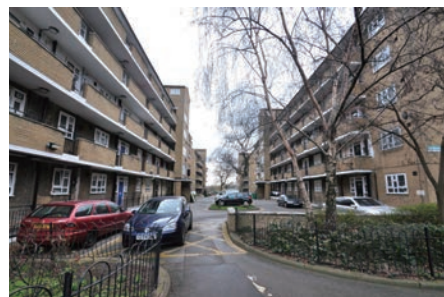
図12. 住棟間の駐車場空間
