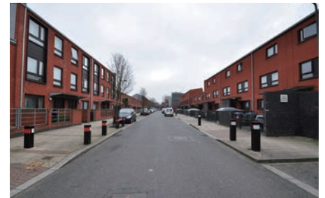
図8. 沿道性のある低層住棟の建設
