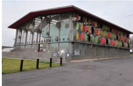
図 12. 子供向けサービス施設の建設
