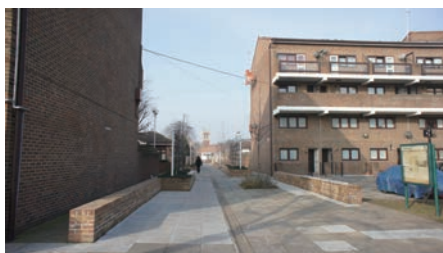
図7. 既存中層住棟間の歩行者通路
