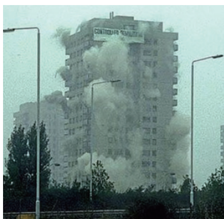
図4. 高層棟の爆破解体 2)
