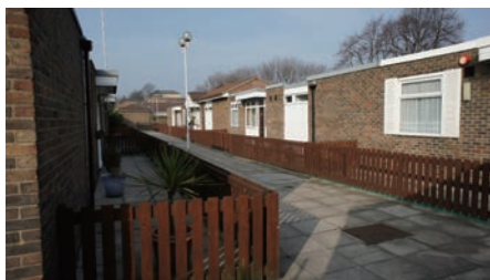
図8. 既存低層住棟間の歩行者通路
