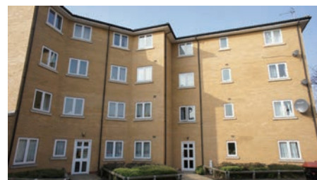
図11. 新しい中層住棟とエントランス
