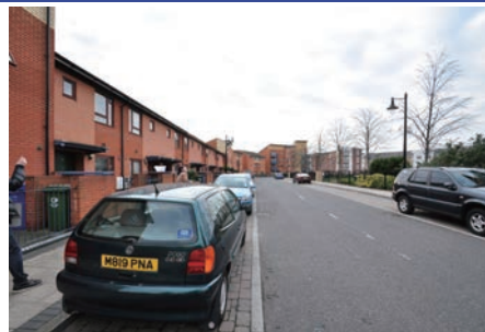
図 11. 凹んだ駐車場
