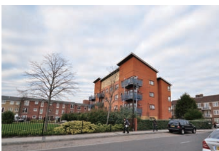
図 10. 公園に隣接する住棟
