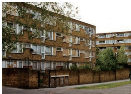
図3. 再生前の空中歩廊 1)
