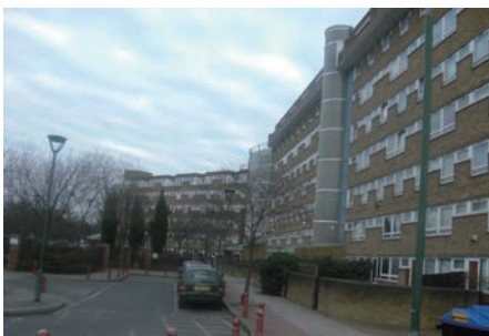
図 7. 既存高層住棟
