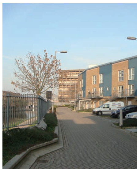
図5. 運河に面する住棟
