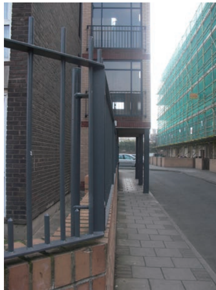
図6. 階段室の新設
