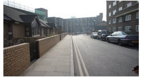
図9. 新設された道と住棟
