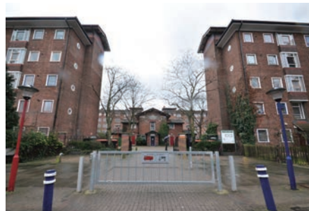
図 10. 中庭へのエントランス
