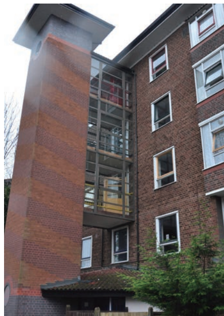
図 11. エレベータと一階エントランス
