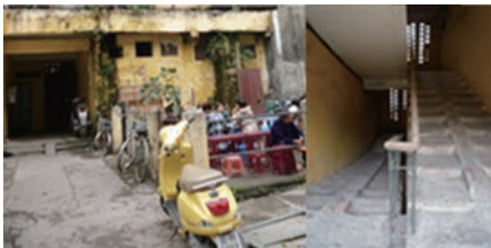
図10 段差に用意されたスロープ
