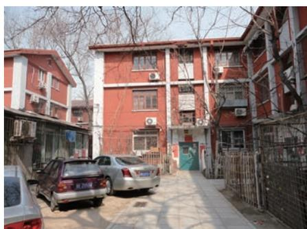
図14. 赤いレンガ造の団地。白い部分は補修により取り付けられた部分
