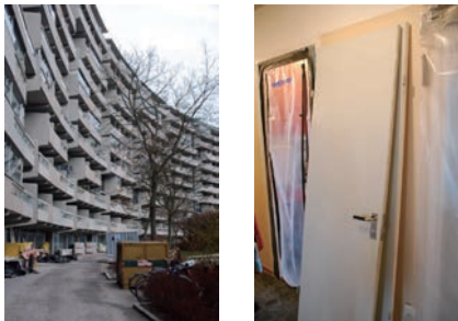
図 5. 住みながら改修進行中 (タビィ団地)
