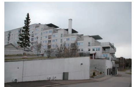
図 10. 板状住棟端部を階段状に減築
