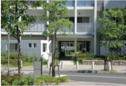
図 17：街路に面したピロティエントランス
