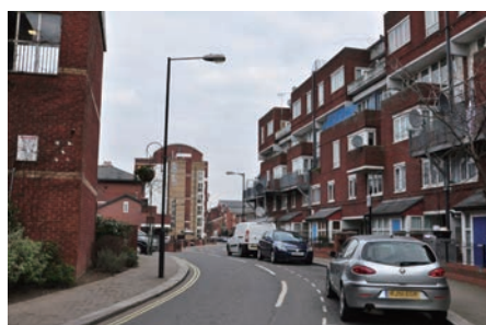
空中歩廊が撤去された街路 11)
