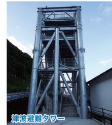
津波避難タワー
