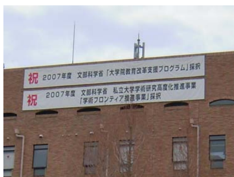
報告会があった近畿大学生命理工学部の建物風景
