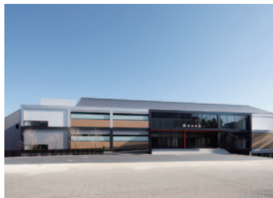
千里山東体育館外観
