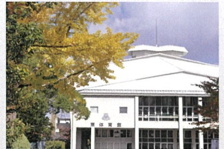
東体育館 解体中
