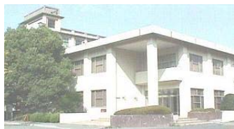
基礎工国際棟Σホール
